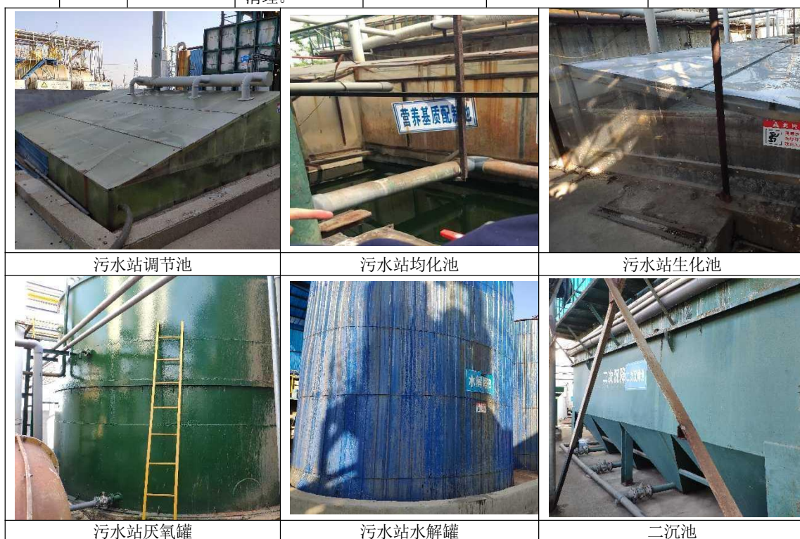
图 8.6-2 池体类储存设施图片
